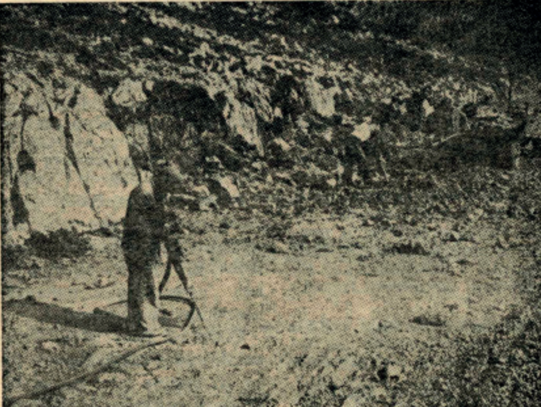
Na cesti Gospić — Karlobag ispaljeno je desetina hiljada mina. Na slici: Pripreme za miniranje
