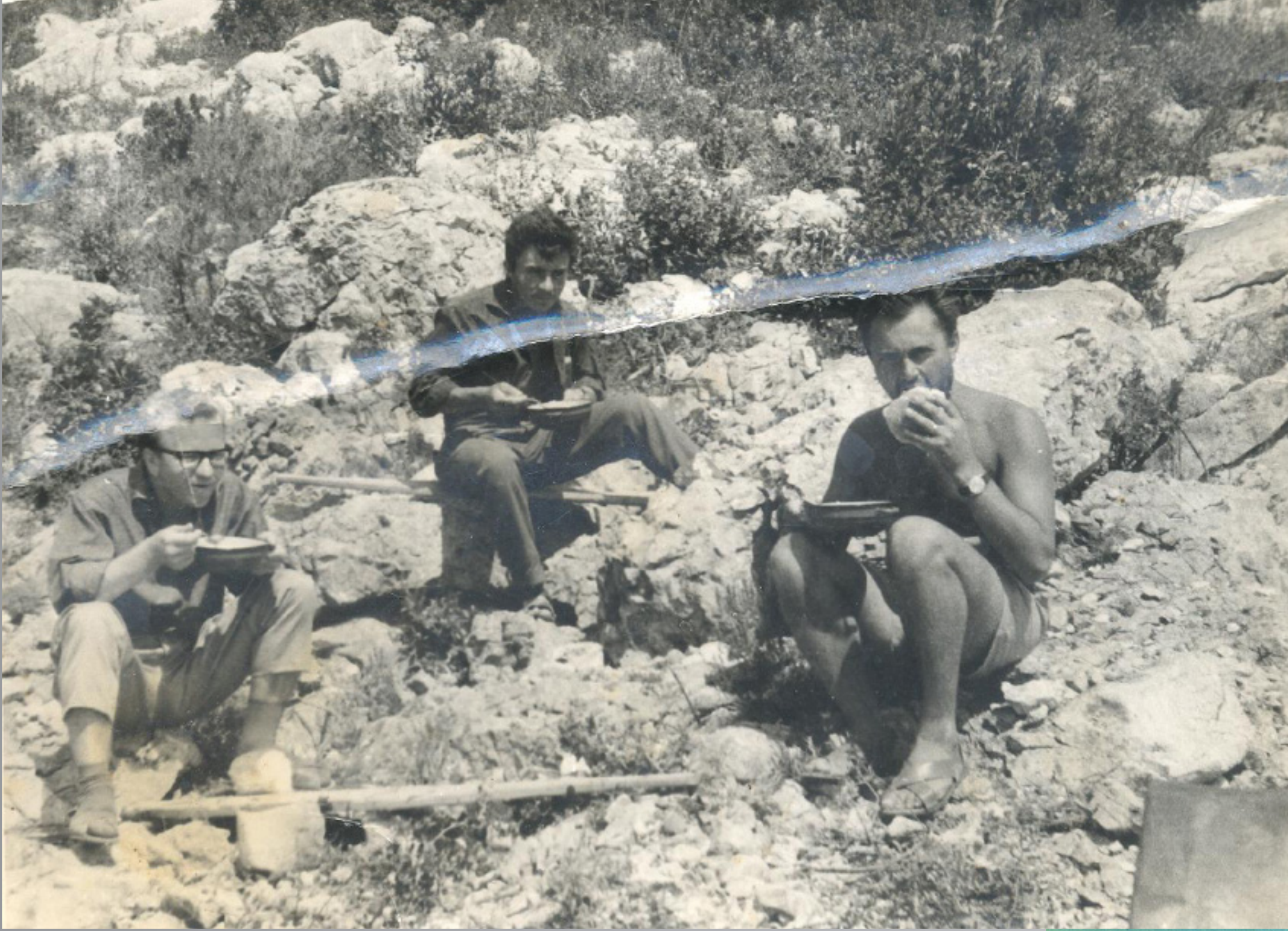
Predah tijekom izgradnje ceste Gospić-Karlobag, 1965. god. HR-DAGS-167. Zbirka dopunskih preslika arhivskog gradiva.
