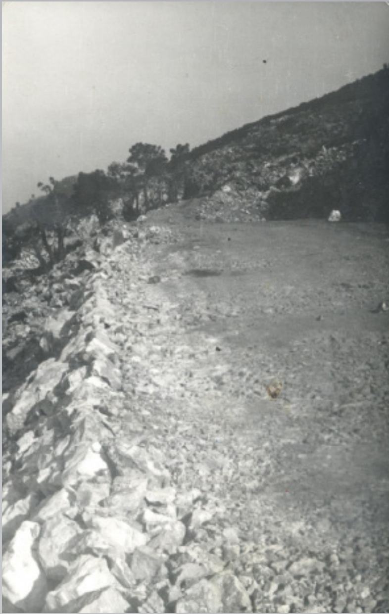
Radovi na trasi ceste Oštarije-Karlobag, 1961. god. HR-DAGS-167. Zbirka dopunskih preslika arhivskog gradiva.
